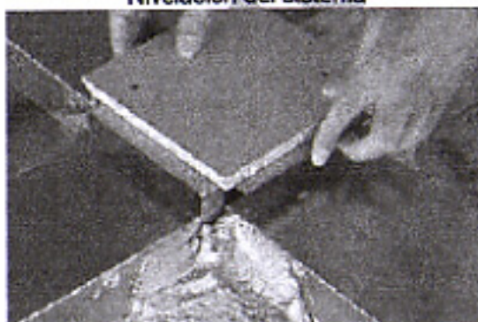
Relleno de huecos entre canaletas
